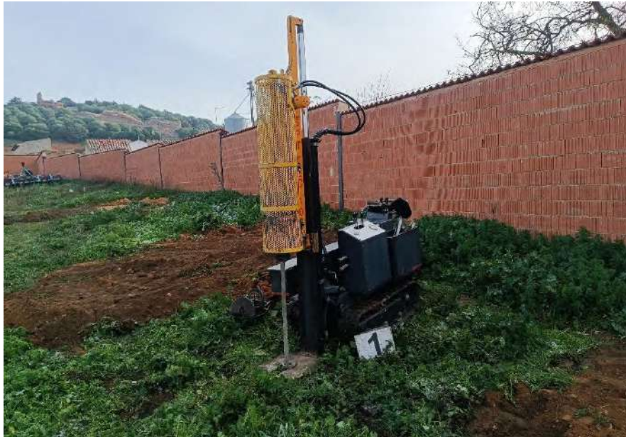
Penetrómetro DPSH-B llevando a cabo uno de los ensayos de penetración.
